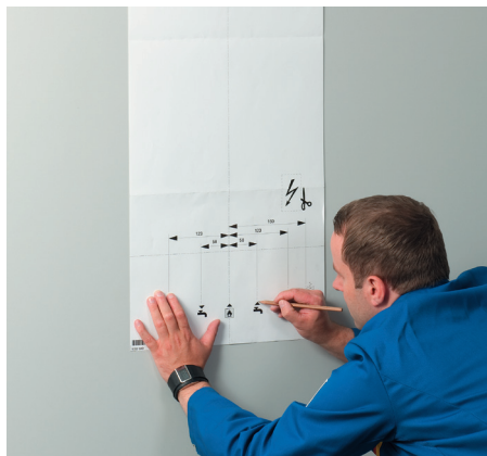
1. Предварительная разметка шаблоном
