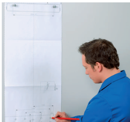
1. Предварительная разметка с помощью монтажного шаблона
